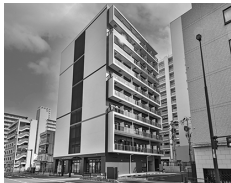
R4年3月完成 鉄筋コンクリート造10階 全104室 宮城県仙台市宮城野区小田原ノ町100 契約年数1年~2年定期建物賃貸借契約
